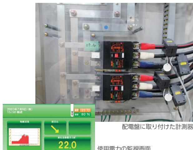
配電盤に取り付けた計測器
