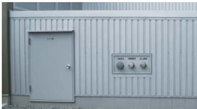
御殿場工場廃液タンク
