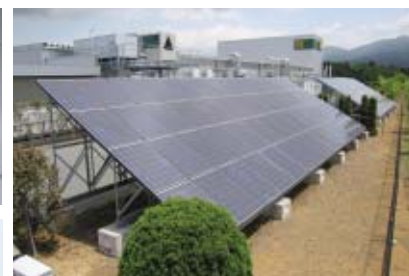
御殿場工場に設置されたソーラーパネル
