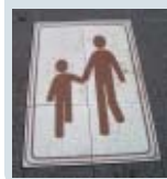
有明街路工事
