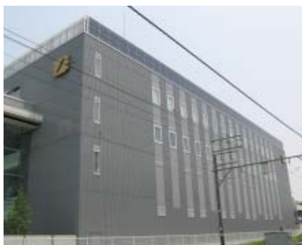
本社の屋上横に設置されたソーラーパネル
