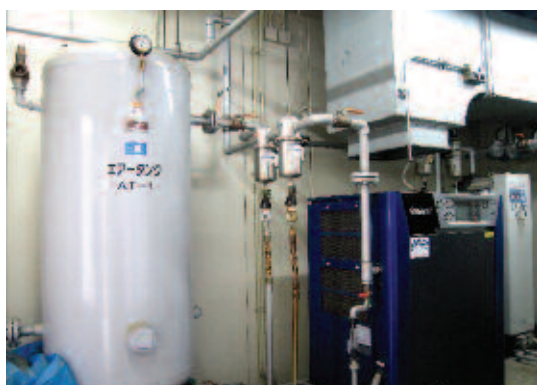
コンプレッサー
