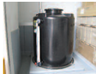
本社の廃液タンク
