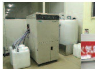
刷版現像廃液のろ過装置
