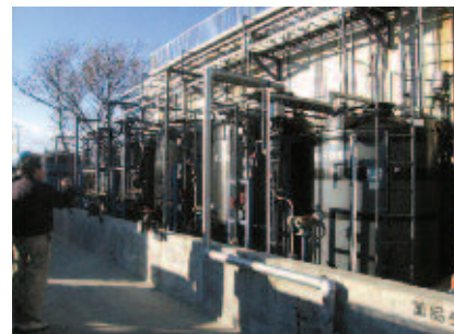
廃液処理の实地確認
