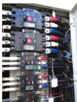
計測器の取り付け
