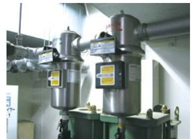
コンプレッサー配管
