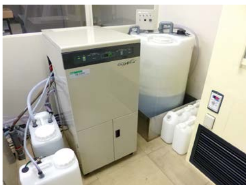
CTP 廃液の濾過装置
