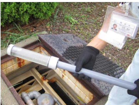
浄化槽の水質検査
