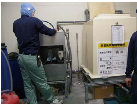
小山工場廃液タンク
