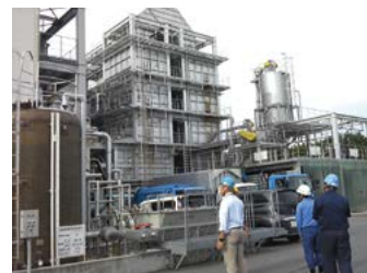
廃棄物処理現地確認の様子
