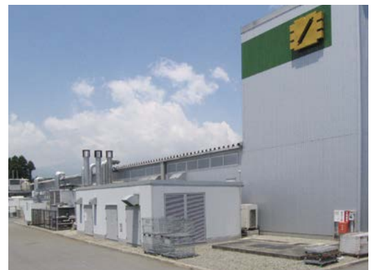
地下重油タンクとボイラー
