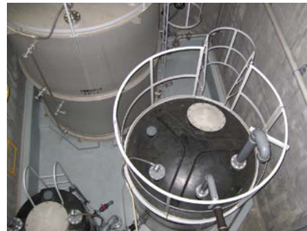
御殿場工場の廃液タンク
