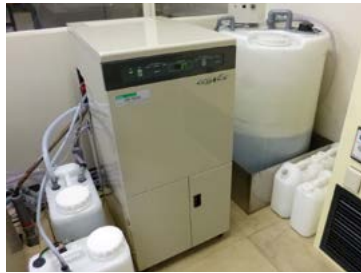
CTP 廃液の濾過装置
