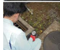
浄化槽の水質検査の様子
