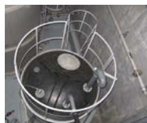
御殿場工場の廃液タンク
