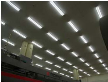
大口工場の LED 照明
