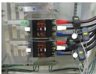
キュービクルに取付けた計測器
