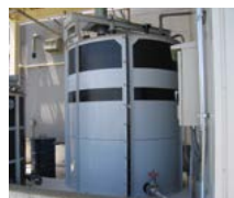
宇都宮工場の廃液タンク
