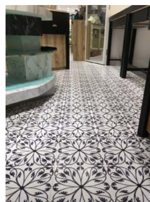
首都圏某アパレルショップ 内装床面 P タイル
