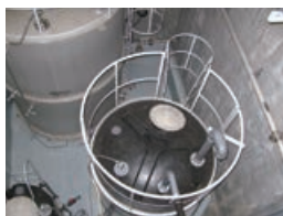
御殿場工場の廃液タンク▼
