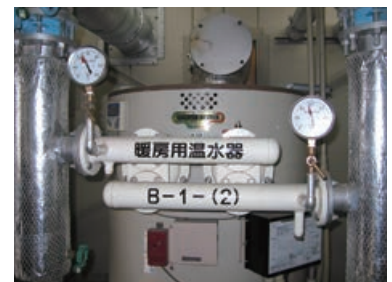
御殿場工場のボイラー
