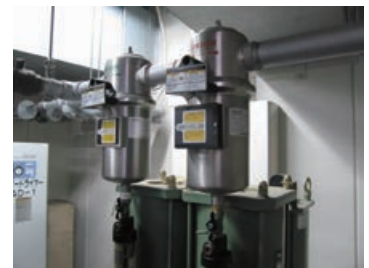
コンプレッサー配管
