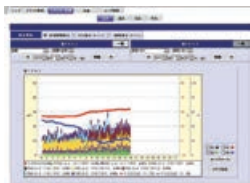
使用電力の監視画面
