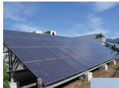
御殿場工場のソーラーパネル
