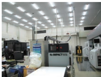
大口工場の LED 照明
