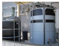
宇都宮工場の廃液タンク▲
