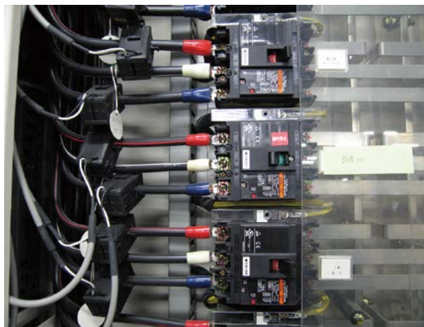
配電盤に取付けた計測器
