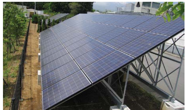
御殿場工場のソーラーパネル
