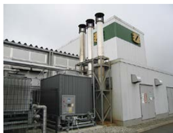
御殿場工場のボイラー
