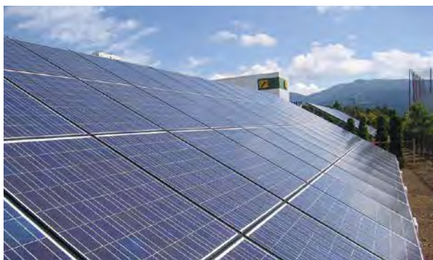
御殿場工場のソーラーパネル
