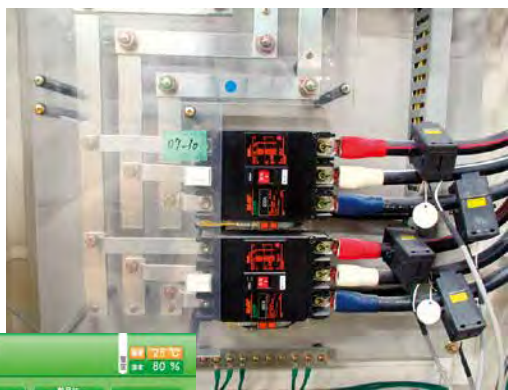
配電盤に取り付けた計測器
