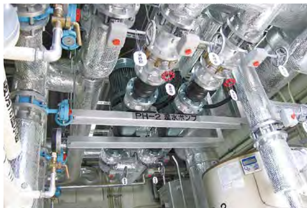
御殿場工場のボイラー
