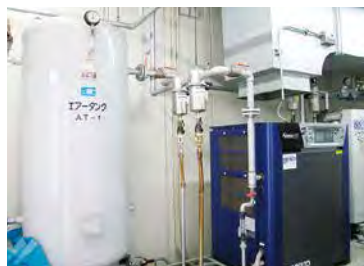
コンプレッサー
