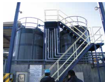
廃棄物処理実地確認の様子
